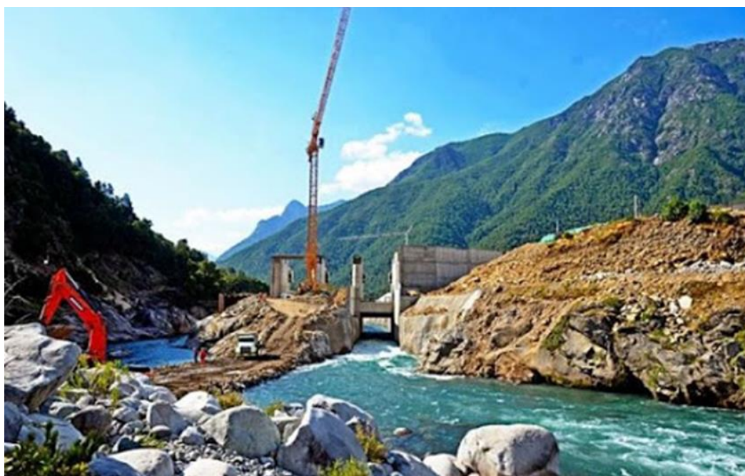
Figura 19. Construcción Central Ñuble.
