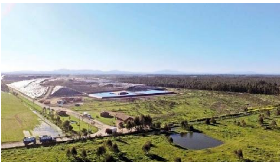
Figura 16. Relleno Sanitario Ecobio.
