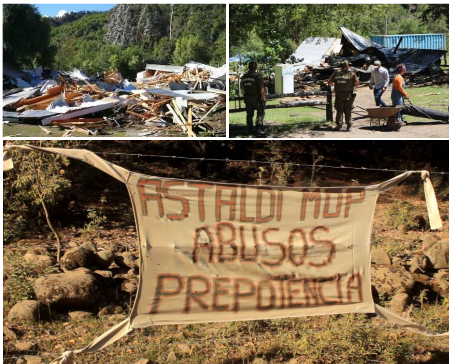
Figura 2. Superior izquierda-derecha, desalojo de viviendas de “pobladores” en sector Las Lumas, San Fabián de Alico. Inferior, carteles de denuncia contra el Ministerio de Obras Públicas (MOP) y empresa privada que realiza las obras del embalse.
