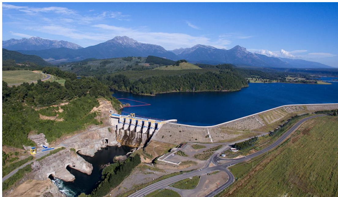
Figura 3. Central hidroeléctrica Angostura.
