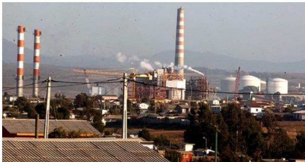
Figura 4. Fase de construcción Central termoeléctrica Campiche.
