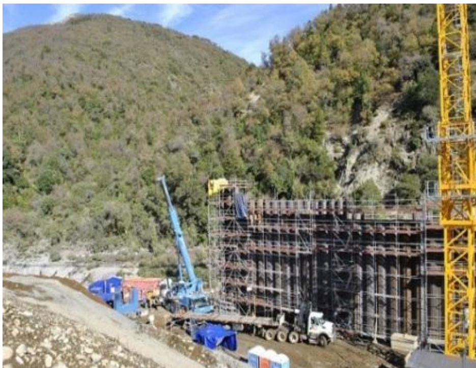
Figura 14. Obras de construcción Central Hidroeléctrica Hidro-Ñuble, actualmente abandonada.
